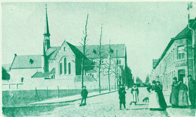
IN HET BEGIN VAN ONZE EEUW - DE PATERSKERK EN HET KLOOSTER STAAN ER REEDS. DE AANPALENDE GROND IS NOG ONBEOUWD. BEMERK OOK DE BOMEN DIE IN DE KOUDE WINTER VAN 1942 VERDWENEN.
