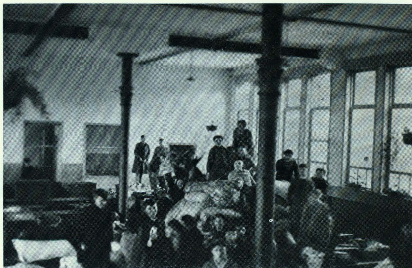
INTERNEN KONDEN, MET VEEL MOEITE, IETS UIT DE ALKOVEN REDDEN. ZO WERD DE STUDIE EEN BERGPLAATS VAN 'T GEREDDE GOED.
