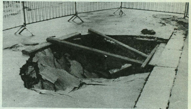
21.7 - Grondverzakking in de Kortrijkstraat (hoek Groeningestr.).
