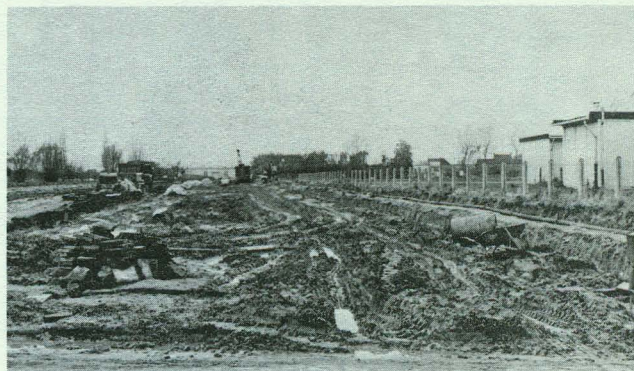
De verlenging van de H. Hartstraat.
