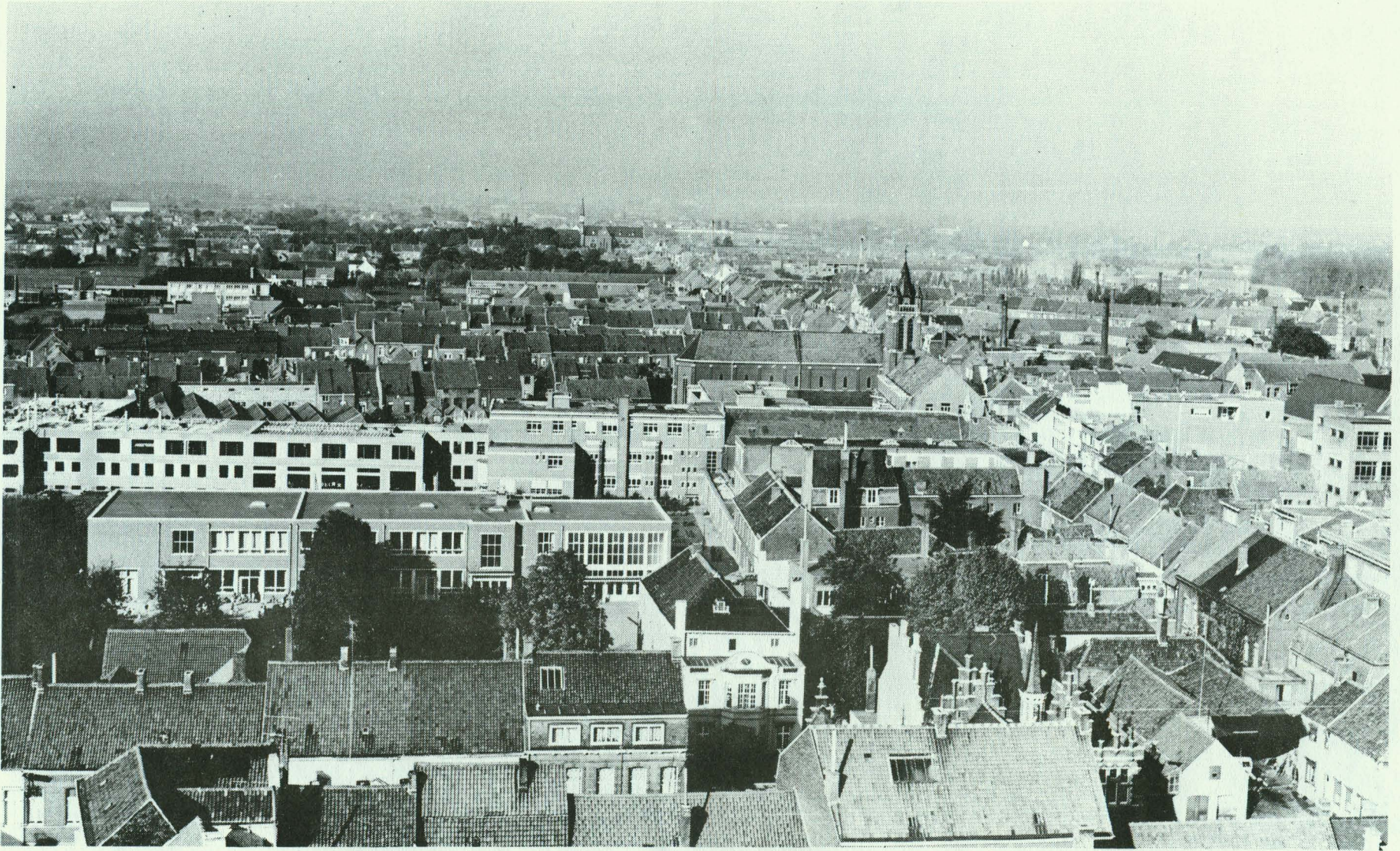
Dit zicht geeft ons een beeld van de ROESELARSESTRAAT vanaf het postgebouw. De toren van de H. HARTKERK en het fijne spilletje van de KAPUCIJNERKERK wijzen de richting van de Roeselaarsestraat aan. Vooraan links bemerken we de vernieuwde klassen van de school van de H. ENGELBEWAARDER en wat verder rijzen reeds de muren op van de vernieuwde kraaminrichting ST.-ANNA.
