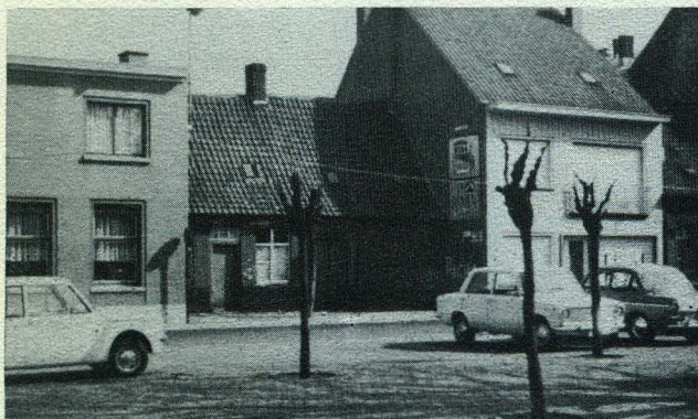
1969 — De noordkant met de oude huisjes vóór ze gesloopt werden.
