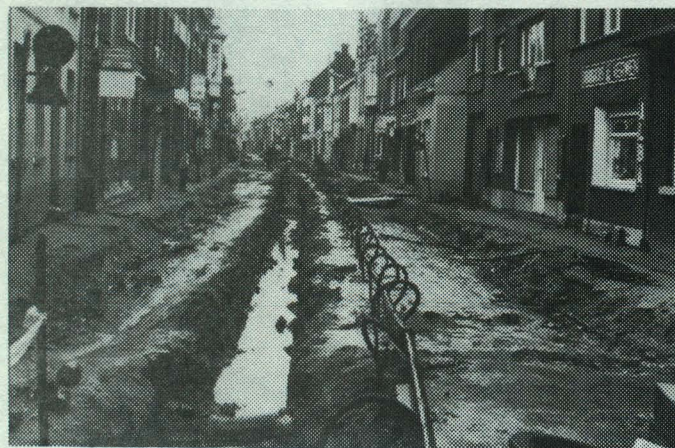
EINDE '74 - BEGIN '75 — Ellende om een nieuwe riolering in de Roeselaarsestraat
