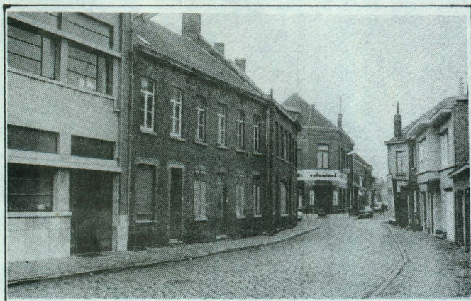
1969 - De huizen die gesloopt werden na de fabriek-brand van de schoenfabriek TANGHE.
