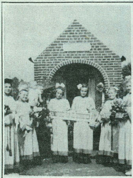
Het kapelletje aan de Vijfwegen dat later diende gesloopt te worden, omdat het zo sterk beschadigd werd bij een aanrijding.
