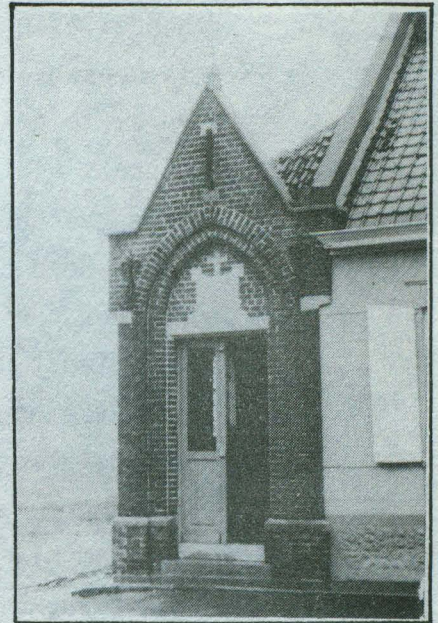
Voorgevel van de kapel langs de ARDOOISESTRAAT
