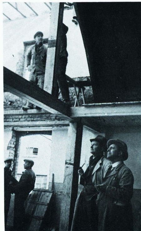
Aannemer K. Lattrez en bouwbeer Anton Strobbe, met kritische blik, tijdens de voorbereidende afbraakwerken van de drukkerijbouw in 1947.
