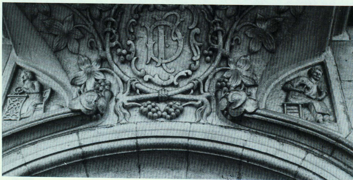
De reuzesluitsteen boven de dubbele ingangsdeur. In het midden de initialen van de firma Defauw, links een schoenstikster en rechts een schoenmaker. Foto Antoon Vandromme.
